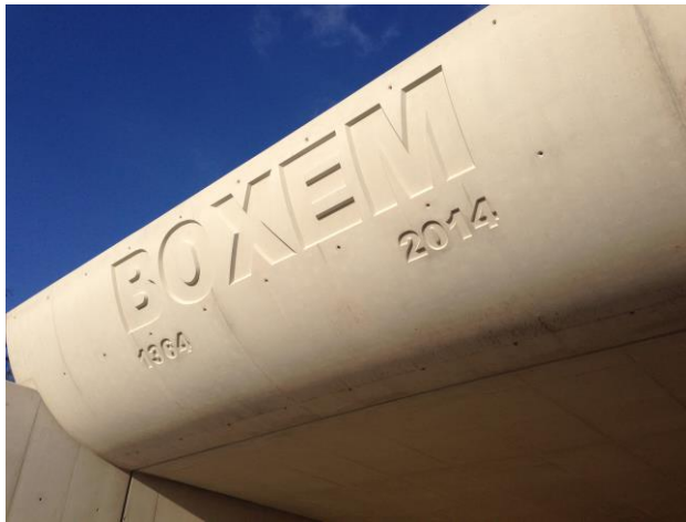
Voorbeeld in het werk gestort schoon beton.
