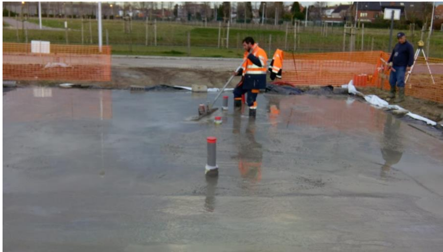
Figuur 8.10 Verdichten met oppervlaktetriller.
