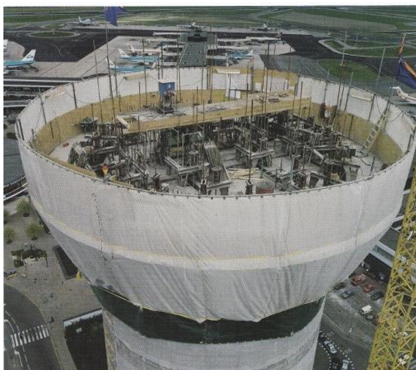
Figuur 8.21 Toren met glijbekisting.
