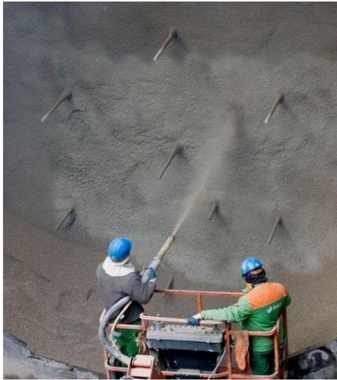
Figuur 8.18 Sputten van beton.
