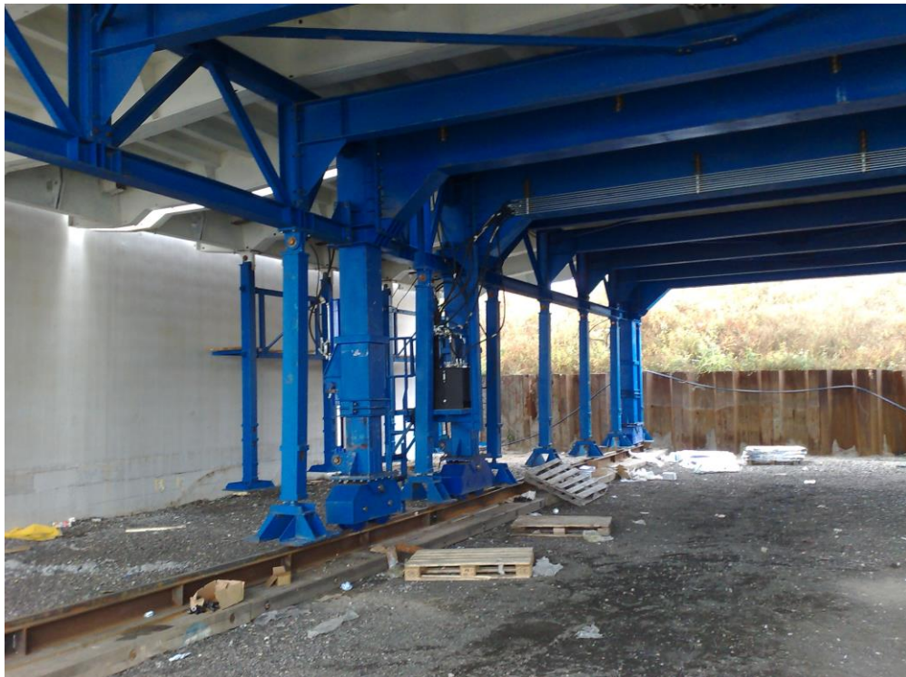
Figuur 8.3 Bekisting voor een tunnel.
