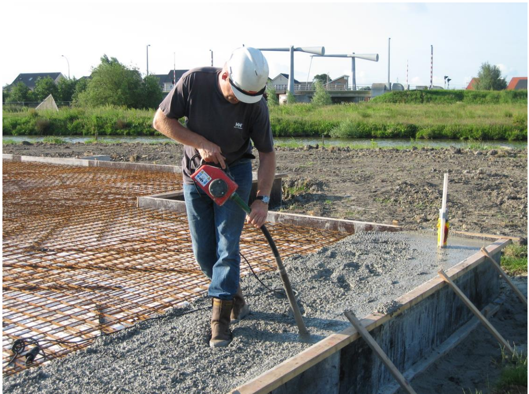
Figuur 8.9 Foto van verdichten met een trilnaald.
