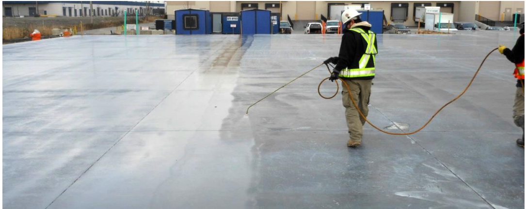
Figuur 8.13 Nabehandelen met curing compound.
